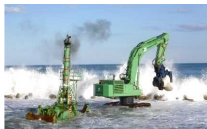
水陸両用ブルドーザを利用した河川工事・海岸工事等
