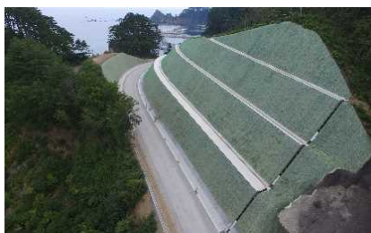
自然共生素材・工法を用いた法面工事
