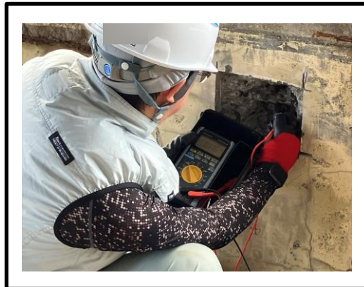
チタンロッド内部挿入陽極工法の施工
