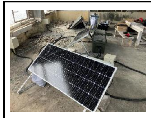
ソーラーパネルと電気防食制御装置
