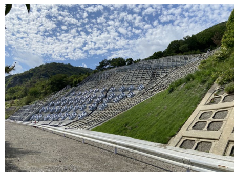
山陽自動車道赤穂地区のり面補強工事
