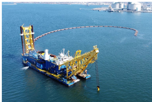
青森県八戸港浚渫工事
