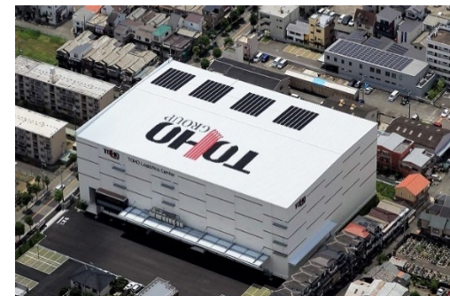
東邦ロジスティクスセンター
