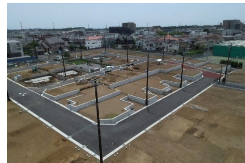
(仮称) 豊四季計画宅地造成工事
