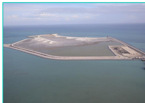
中城湾港土砂処分場護岸築造工事
