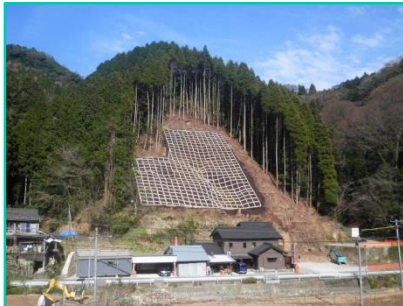
鶴地区治山工事 (法面保護工事)
