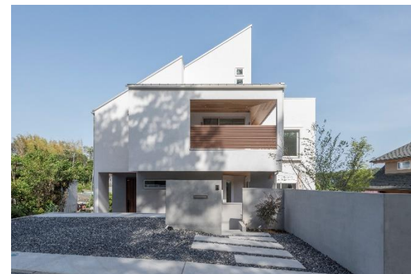
タツミプランニング 施工物件
