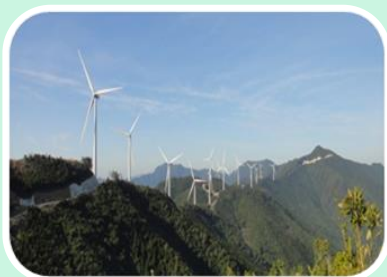
再生可能エネルギー関連工事
