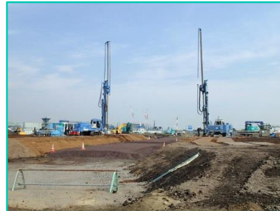
羽田空港跡地地盤整備工事 (地盤改良工事)
