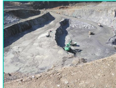
小石原川ダム工事 (爆砕工事)
