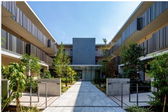
高松建設 東京 都立家政・Nプロジェクト
