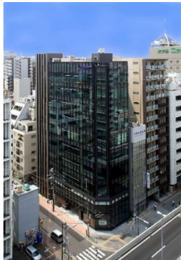
高松建設 東京 御徒町・日本電計(株)新本社ビル
