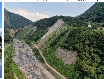
東興ジオテック 葛葉下流山腹工その12工事
