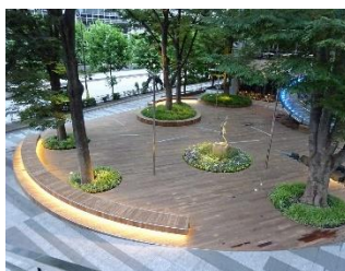
エムズ 霞が関ビルディング けやき広場ウッドデッキ更新工事(主)十日町日間塩沢線単舗装道補修工事
