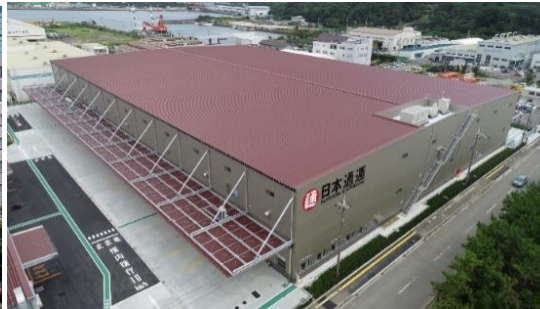
高松建設 大阪 日本通運(株)和歌山倉庫
