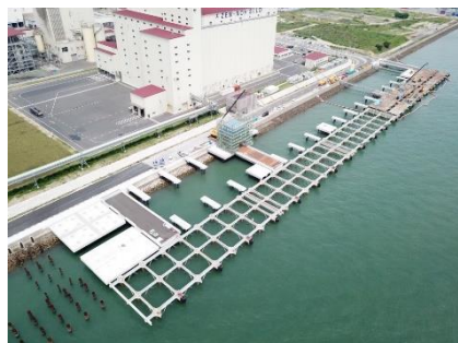
みらい建設工業 水島港玉島地区岸壁(-12m) 築造工事(その4)
