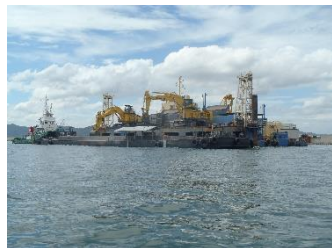
青木マリン 水島港玉島地区航路・泊地(-12m)等 浚渫工事
