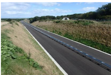
あすなろ道路 一般国道44号 根室市 温根沼東舗装工事
